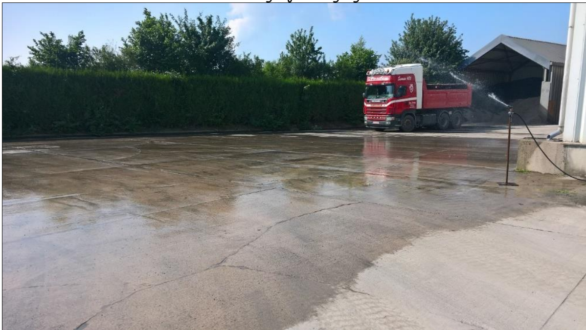
Foto 4 Betonverharding bij de uitgang van de laadzone
