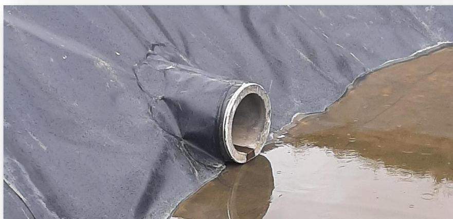
On distingue deux types de canalisations au sein du site. Une canalisation est destinée au déversement des eaux pluviales. Ces eaux passent par un séparateur d'hydrocarbures et un déboureur avant d'être rejetées dans un bassin d'orage privé.
